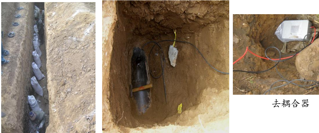
图 5 动态杂散电流治理的施工现场图
