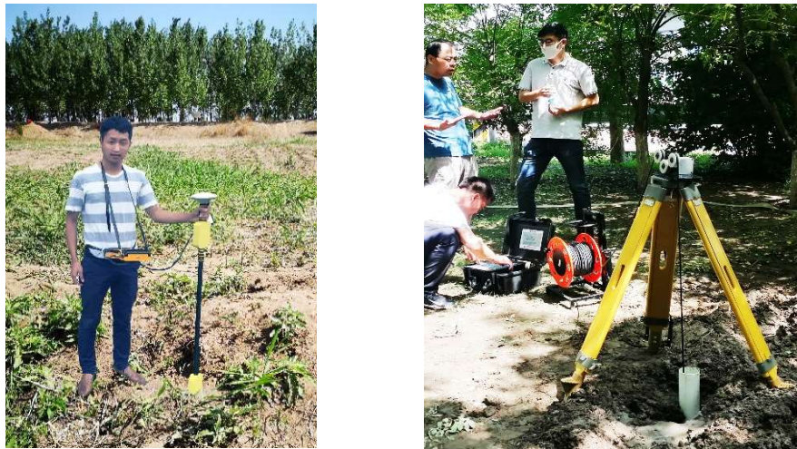
图 5 检测施工现场
